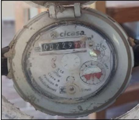
**Fig. 14 Medidor de agua.**
